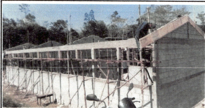
FOTO 5 PREPARANDO PARA EL ENTECHADO.
