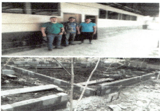
FOTO 1 SE INICIO EL TRABAJO DE TRES AULAS
