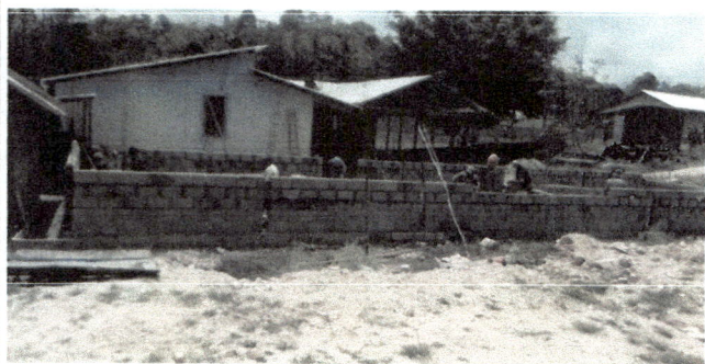
FOTO 3 LEVANTANDO PARED DE SIETE HILADAS DE BLOCK Y TRES AULAS
